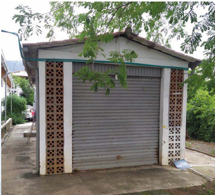
Deposito actual de residuos
